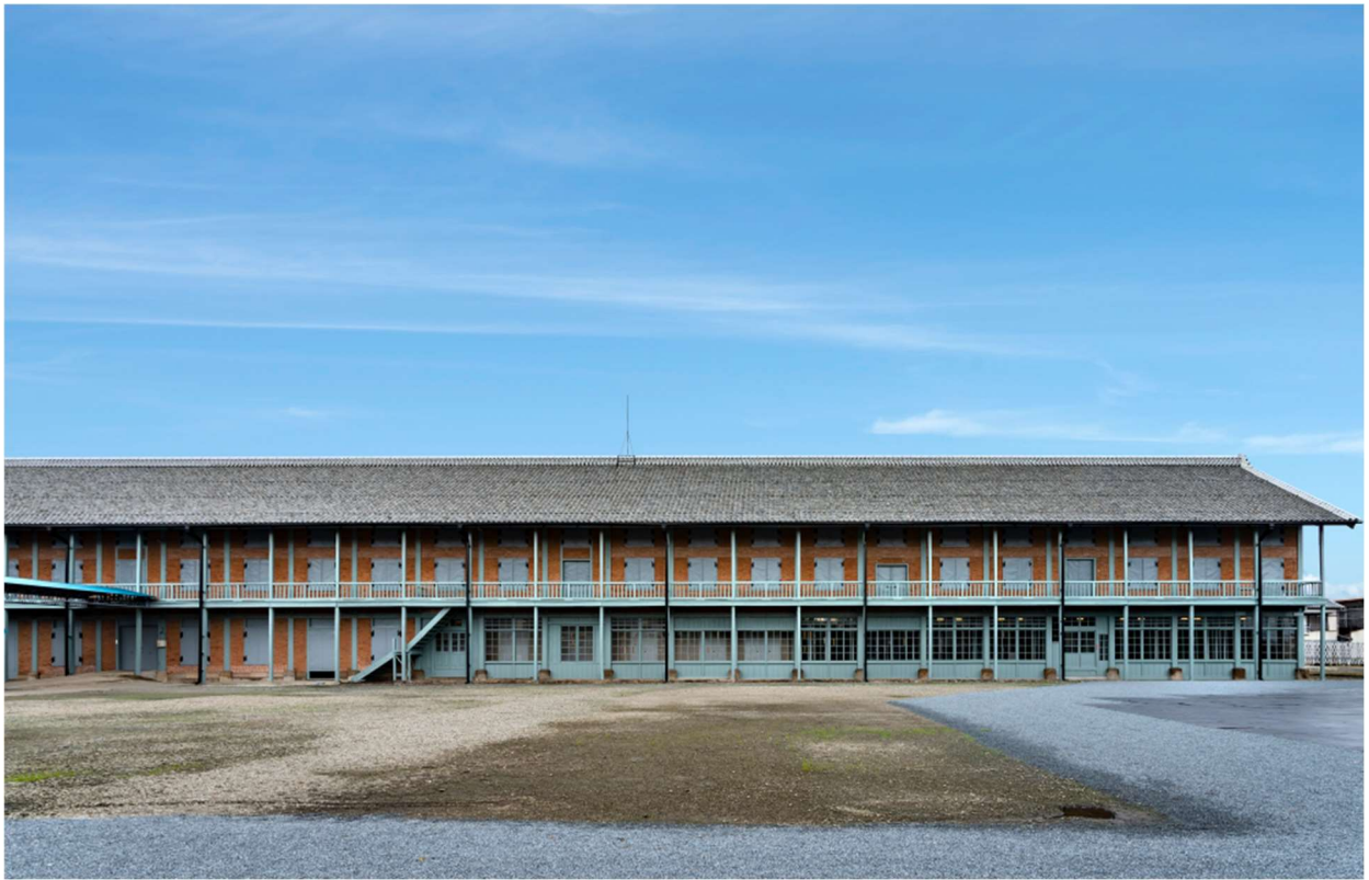
図1 西置繭所外観／撮影：瀬脇 武
