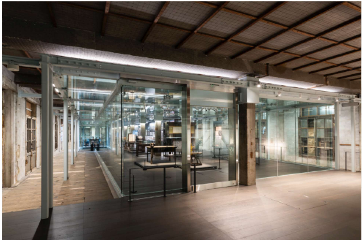
図2 西置繭所 1F 「ハウス・イン・ハウス」内部に整備した資料展示室／撮影：瀬脇 武
