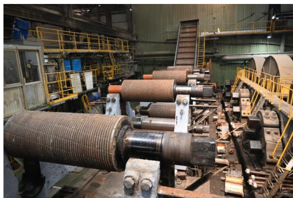
図2 1928年製善化糖廠のコンプレッサのメンテナンス作業 出典: 著者撮影
